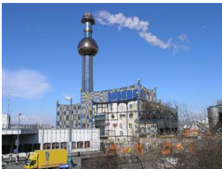
Figura 9 - Unidade de Recuperação de Energia
